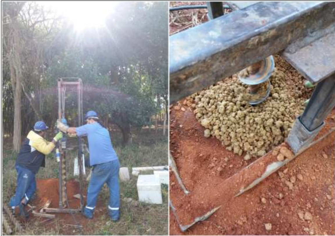
Figura 7.1: Sondagem realizada para instalação dos Poços de Monitoramento
