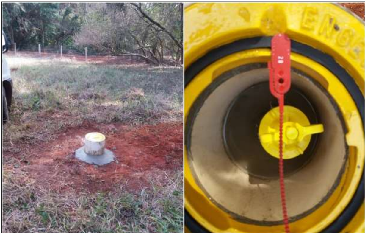
Figura 7.2: Poços de Monitoramento das águas subterrâneas
